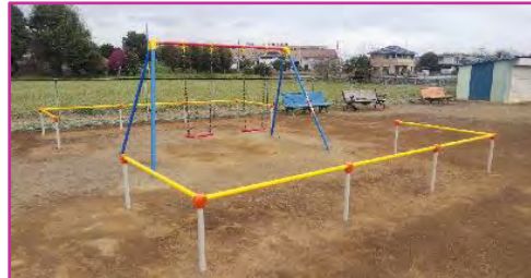
児童遊園ブランコ周りに柵が無く、子供たちが危険でしたので柵の設置を要望しました。
