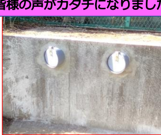
岸町一丁目地内 内水被害多発地域に自治会協力のもと雨水排水管を設置しました。
