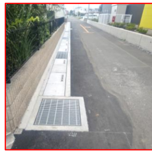
並木地内。宅地開発地域への 道路側溝新設
