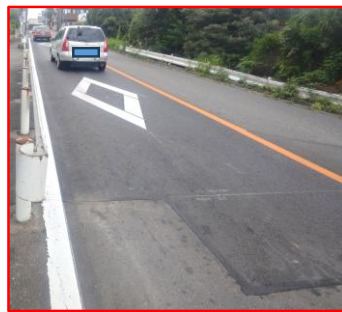
岸町一丁目地内。 市道わだちの舗装改修
