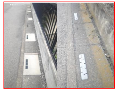
並木地内。 道路側溝ふたの改修・交換
