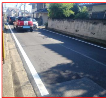
岸町二丁目地内。 市道わだちの舗装改修
